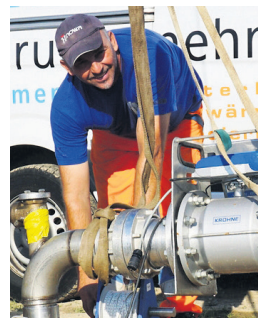
Erste Pumpversuche: In Zufikon wurde erfolgreich nach Wasser gebohrt.
